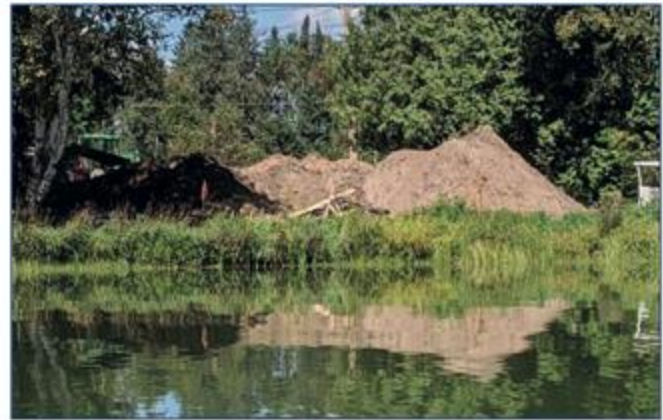
Exemple à ne pas reproduire lors de travaux à la maison. Crédit photo : COBALI
